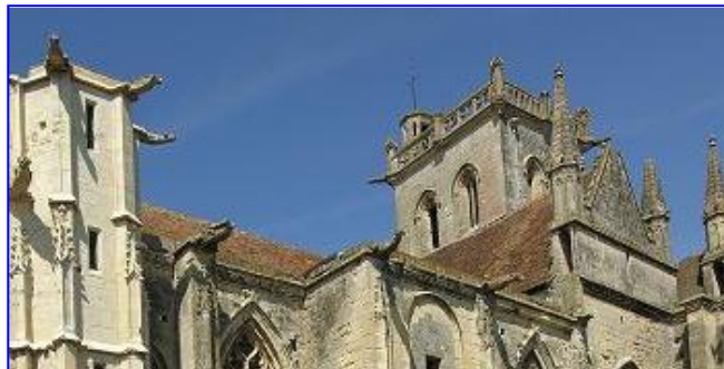
La Tour carrée de l'église était un lieu de guet pendant les périodes de guerre avec les anglais Sur les toits, le « chemin des gargouilles », autrefois protégé par une balustrade, reliait les clochetons sous lesquels on remarque une petite porte qui permettait le passage des pèlerins lors des processions.
