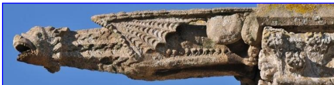
Réalisation : C. Le Callonec – Photos : JC Le Callonec Sources : V. Carpentier
